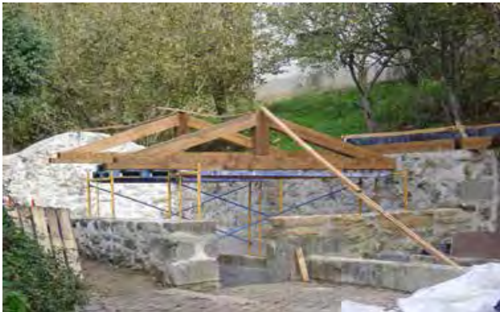
Berriteta lanak. Trabajos de rehabilitación.
