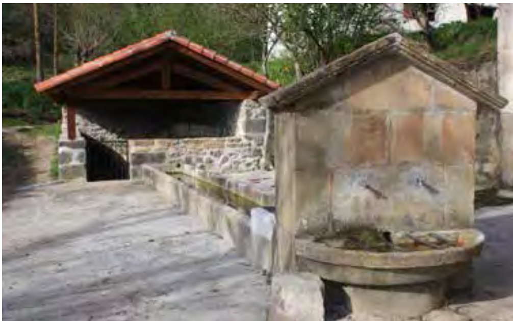
Egiarretako Iturria eta garbiketa egungo iturarekin Estado actual de la fuente y lavadero de Egiarreta.
