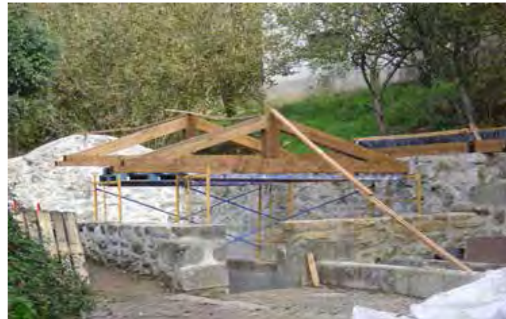
Berriteta lanak. Trabajos de rehabilitación.
